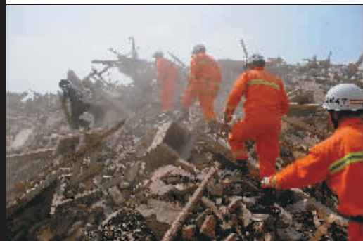
5月15日,四川青川县木鱼中学搜救人员在紧张工作。
